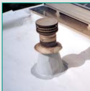
Achteraf aangebrachte dakdoorvoer.
